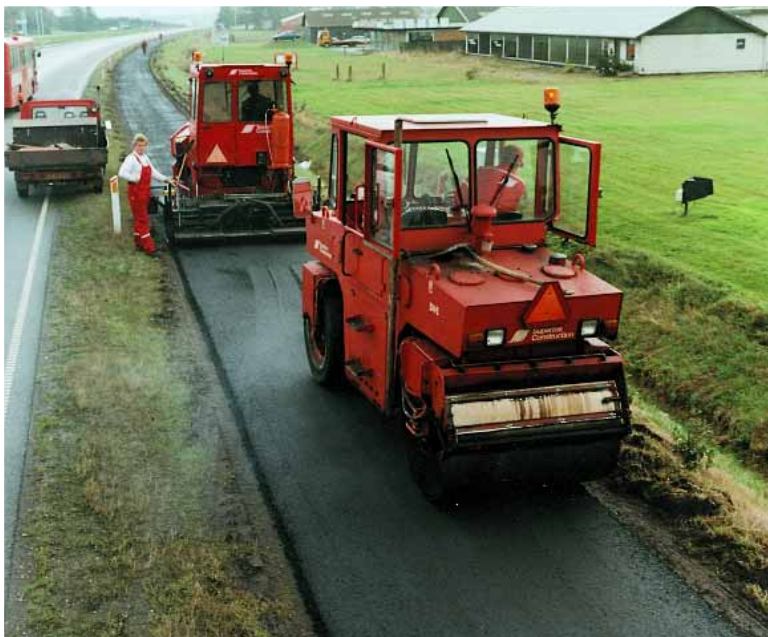
Udlægning på sti.
