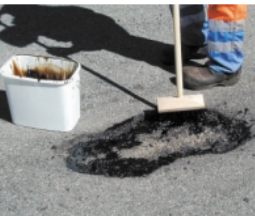
Klæbning med bitumen.
