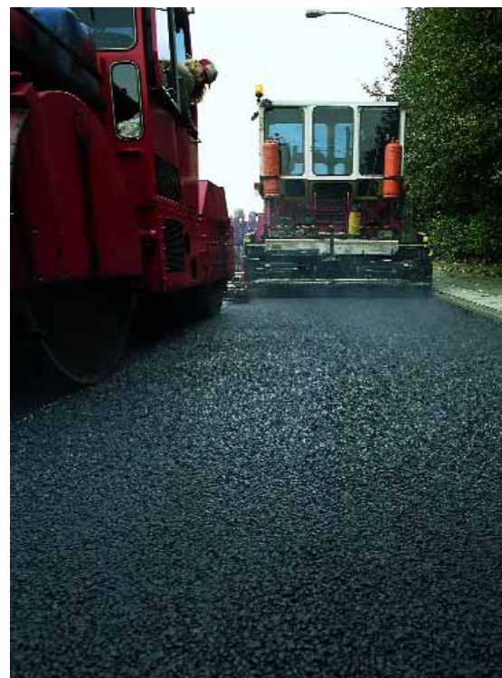
Udlægning af skærvemastiks
