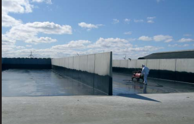
Silo med betonbund forsegles.
