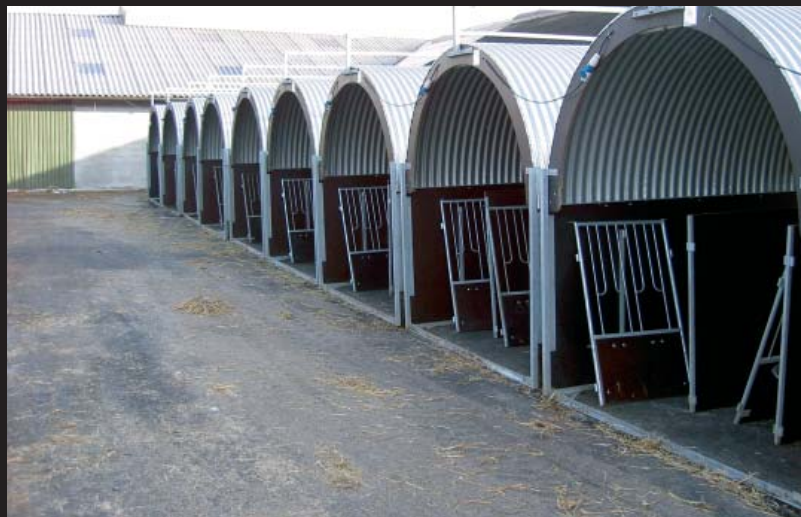
Asfaltbund til kalvehytter.
