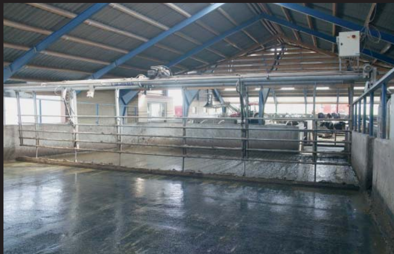
NCC Asfalt Mastic på opsamlingsplads.
