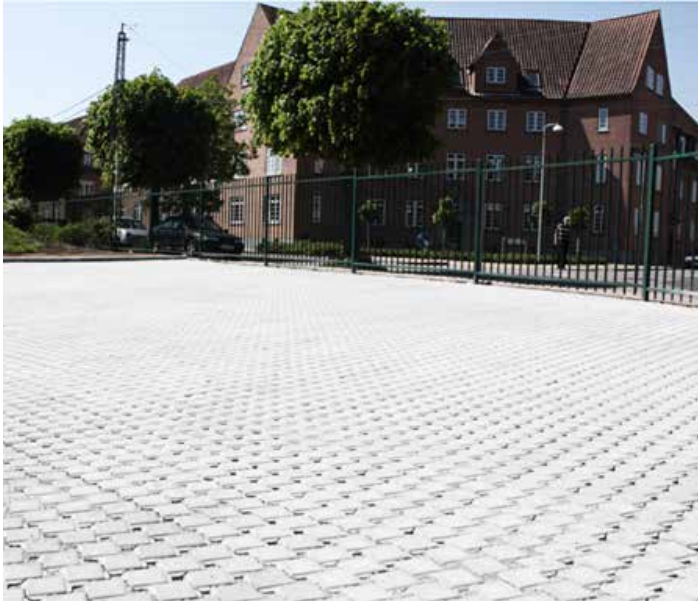
Det færdige resultat ved VandCenter Syd, Odense. Permeabel Belægning og Wadi.
