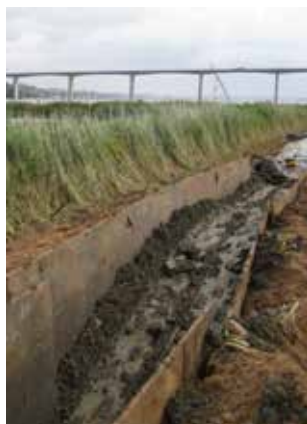
Tætning af diger og kystsikring
