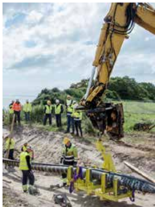
Varmaefledning af højspændingskabler
