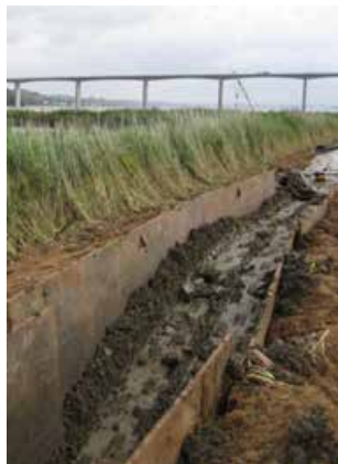
Tætning af diger og kystsikring
