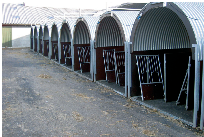
Asfaltbund til kalvehytter.
